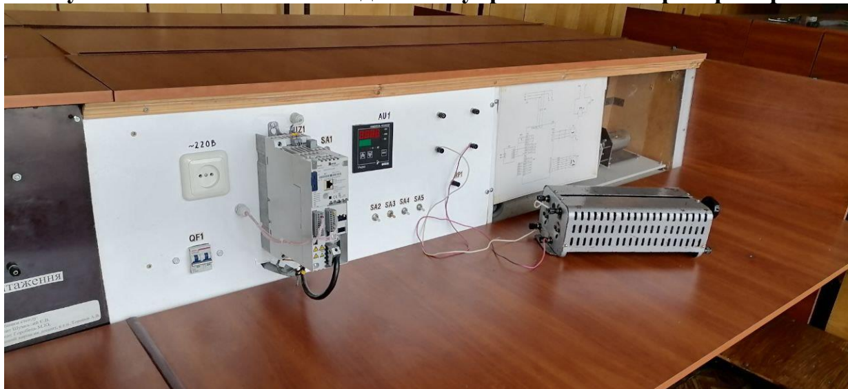
Рисунок 9 - Загальний вигляд стенду лабораторної роботи №8
